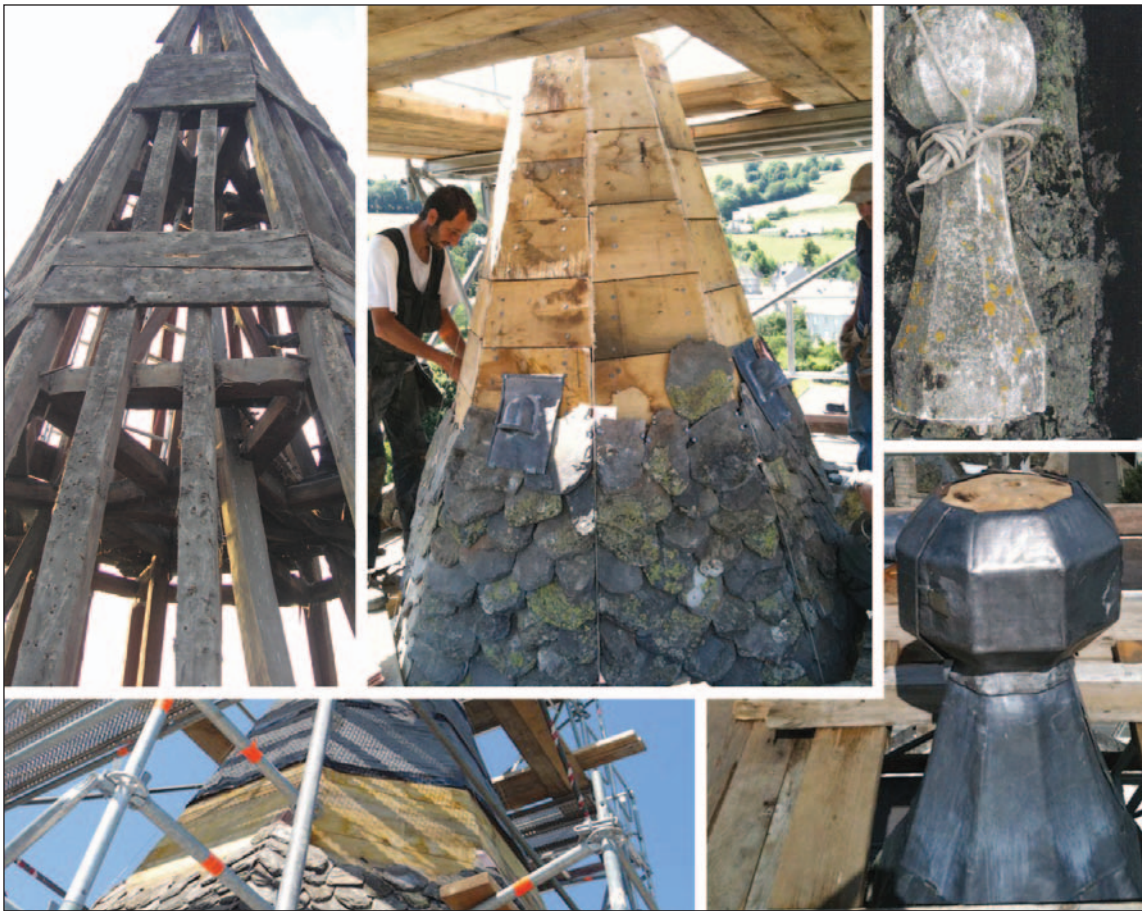
Restauration du clocher. En haut à gauche, la charpente en 2009 et en haut à droite la boule pinacle en pierre, sculptée par M. Bénézit. En bas à droite, l'épi de faitage du clocher qui a été nouvellement mis en place. En bas à gauche, les échafaudages durant les travaux et en haut au centre, M. Bioulac, couvreur, fixant les lauzes sur la flèche du clocher.
